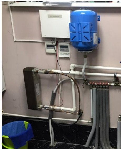
Рис. 2. (А, Б) Внешний вид теплового насоса воздух-вода
