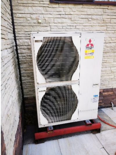
Рис. 2. (А, Б) Внешний вид теплового насоса воздух-вода
