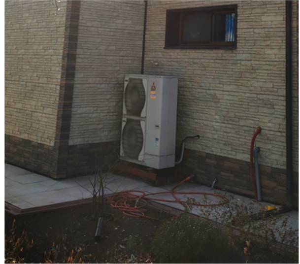
Рис. 2. (А, Б) Внешний вид теплового насоса воздух-вода
